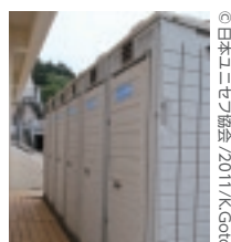
設置された仮設トイレ
